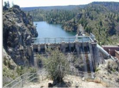
Long Lake Dam
