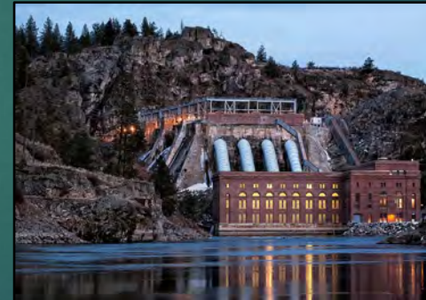
Long Lake Dam, Avista Corp
